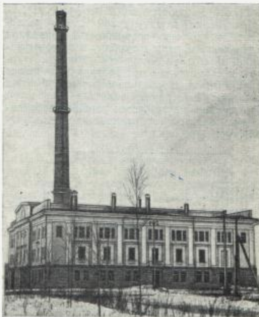
Рис. 1. Общий вид здания атомной электростанции.
